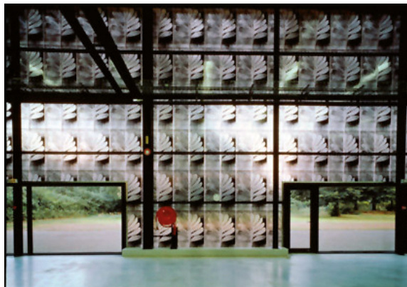
Exteriores e interiores del almacén Ricola con el revestimiento de paneles de metacrilato serigrafiados
